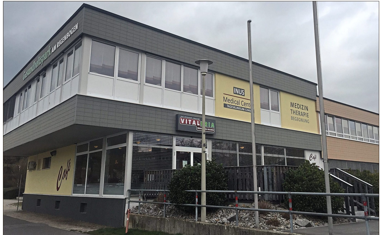
Das Verwaltungsgebäude der Inus bekommt einen Anbau in Holzbauweise. Die Cafeteria bleibt erhalten, zieht allerdings ein paar Meter weiter in Richtung Straße. Fotos: Geiling-Plötz
